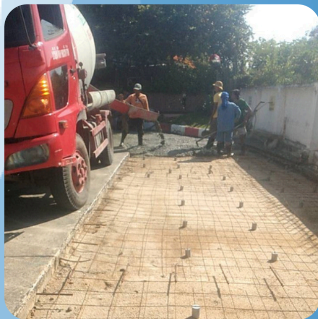
ส่งคอนกรีต หน้างานซ่อมพื้นถนน หมู่บ้านฟ้าปิยมณ
