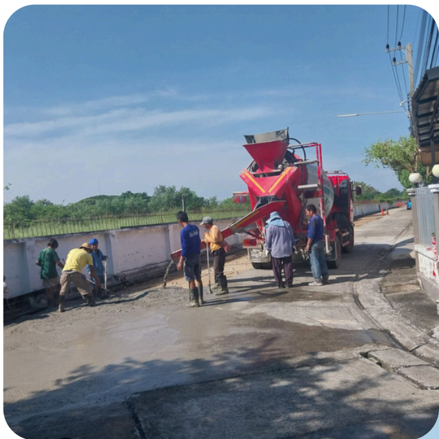
ส่งคอนกรีต หน้างานซ่อมพื้นถนน หมู่บ้านฟ้าปิยมณ
